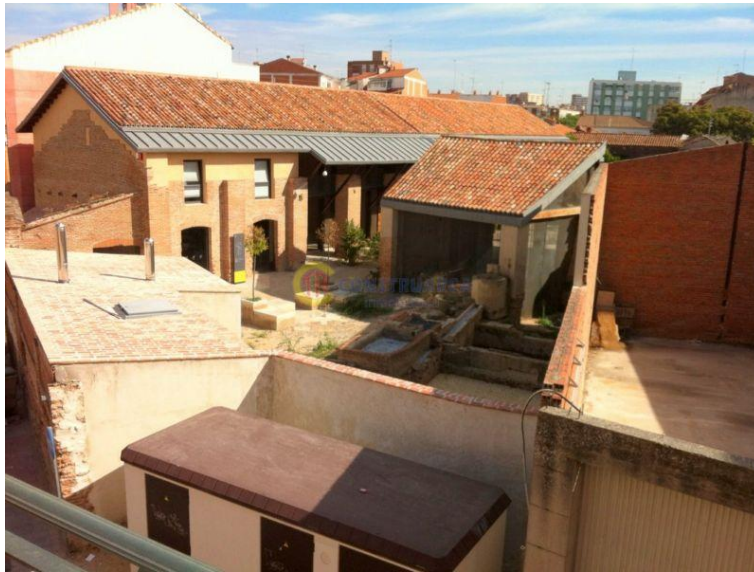
LA ANTIGUA LEÑERA, EL COBERTIZO Y HORNOS Y LA CASETA DE INSTALACIONES CON LOS ESPACIOS LIBRES (EXTRAMUROS CON CUBIERTA MARRÓN: CENTRO DE TRANSFORMACIÓN DE LA COMPAÑÍA ELÉCTRICA)
