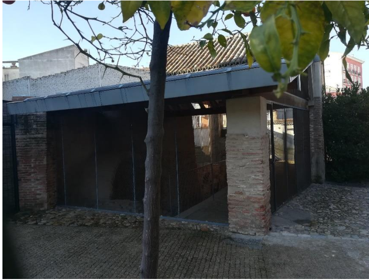
21.- VISTA DE CERRAMIENTO DE MALLA DE ZONA HORNOS/COBERTIZO
