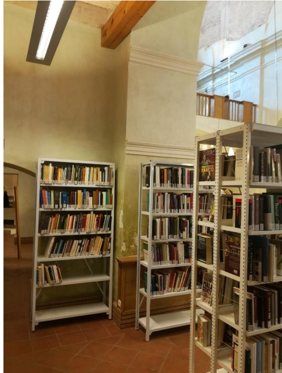
11.- DAÑOS EN PARAMENTOS INTERIORES DE LA IGLESIA POR HUMEDAD DE CAPILARIDAD Y FILTRACIONES DE PARCELA COLINDANTE. (ID. ID)
