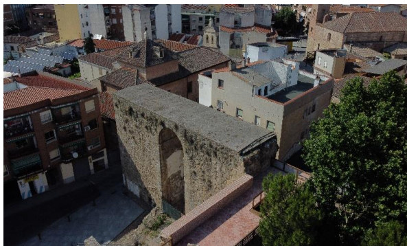
Torre albarrana en el tramo Charcón II
