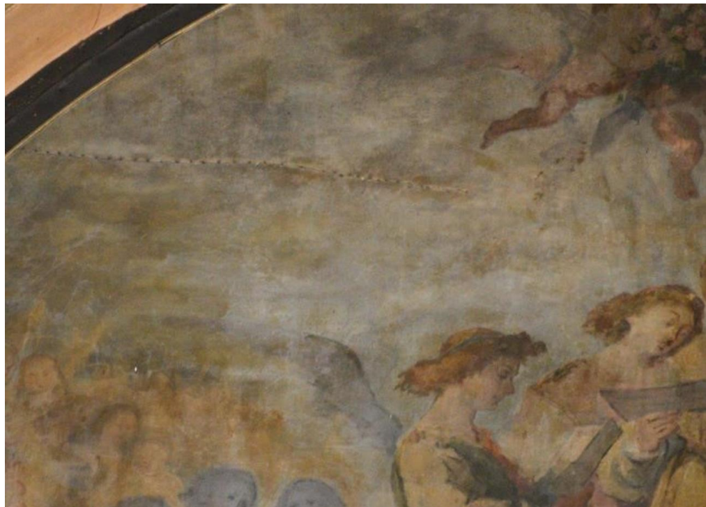
Pintura del tímpano, área izquierda. Roturas o cortes rematados con clavos, manchas por adhesivos y deterioro del barniz.
