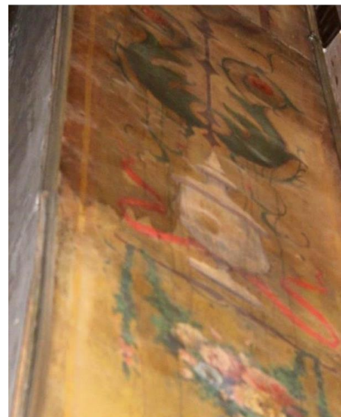
Manchas por adhesivos y deterioro del barniz.
