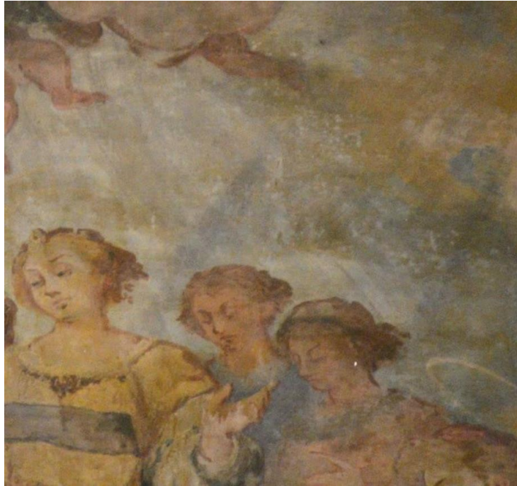
Pintura del tímpano, área central. Manchas por adhesivos y deterioro del barniz.
