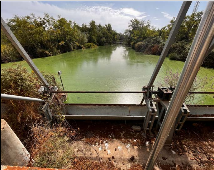
FOTOGRAFÍA 03. ACCESO AL CANAL
