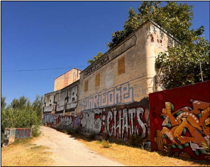
FOTOGRAFÍA 04. RECUPERACIÓN FACHADAS EDIFICIO SUR
