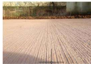
Ejemplo de pavimento de hormigón coloreado con acabado rayado
