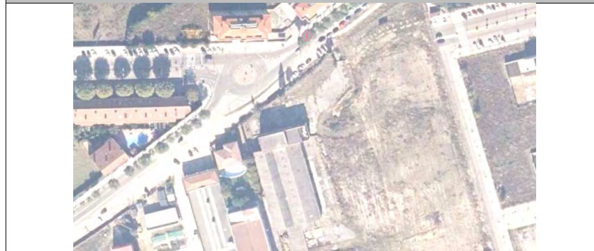
FOTOGRAFIA SITUACIÓN ACTUAL PMV-6
