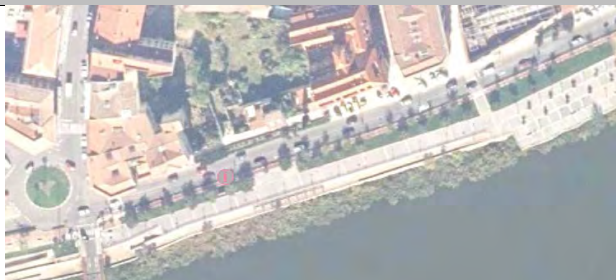
FOTOGRAFIA SITUACIÓN ACTUAL PMV-1
