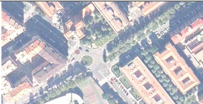
FOTOGRAFIA SITUACIÓN ACTUAL PMV-7
