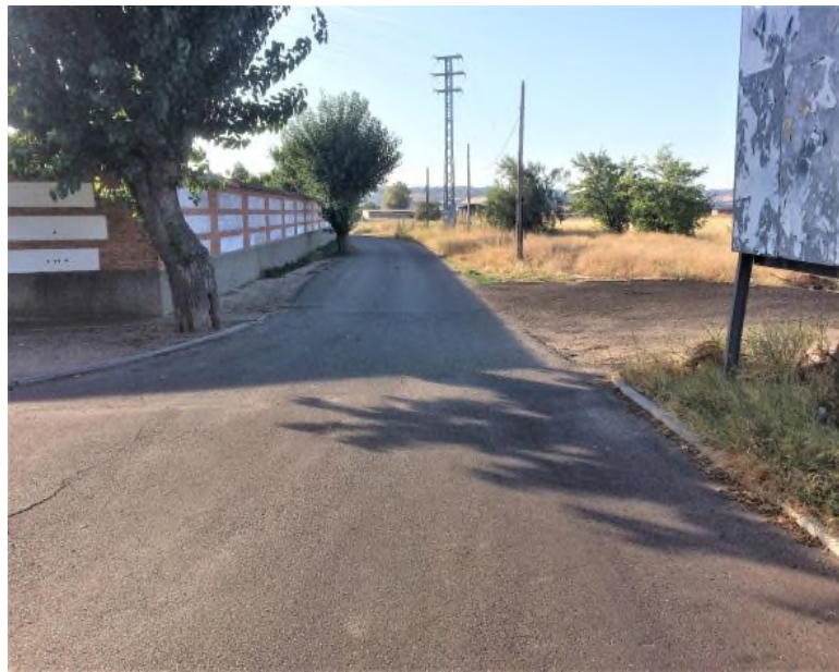
FOTO 32. Camino del Barro y de Cabañuelas, Tramo A
