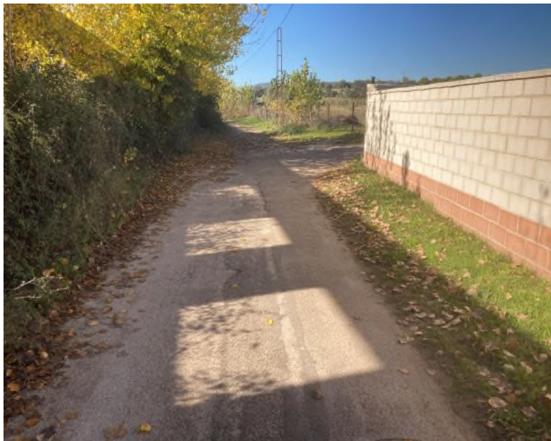
FOTO 18. Camino de Valdelacruz, Tramo D
