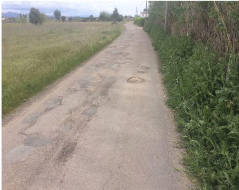
FOTO 9. Camino del Puntal, Tramo A
