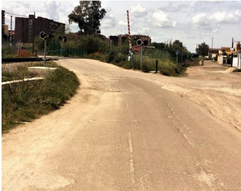
FOTO 3. Camino del Pilar, Tramo B
