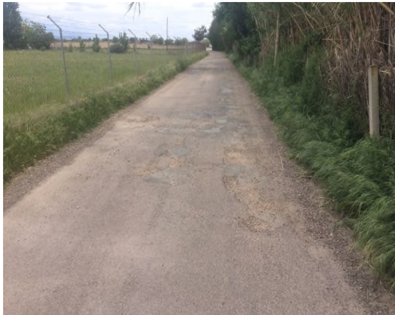
FOTO 10. Camino del Puntal, Tramo A
