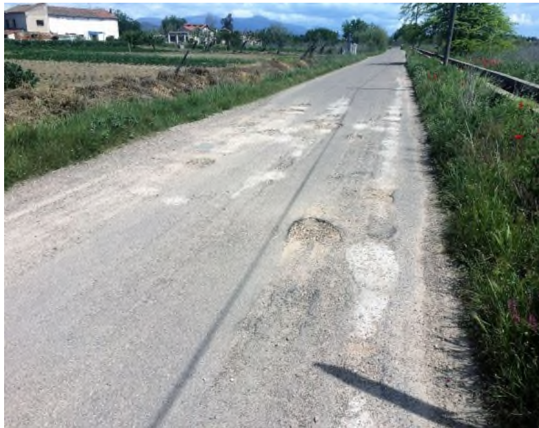
FOTO 4. Camino del Pilar, Tramo B
