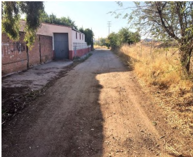
FOTO 34. Camino del Barro y de Cabañuelas, Tramo B
