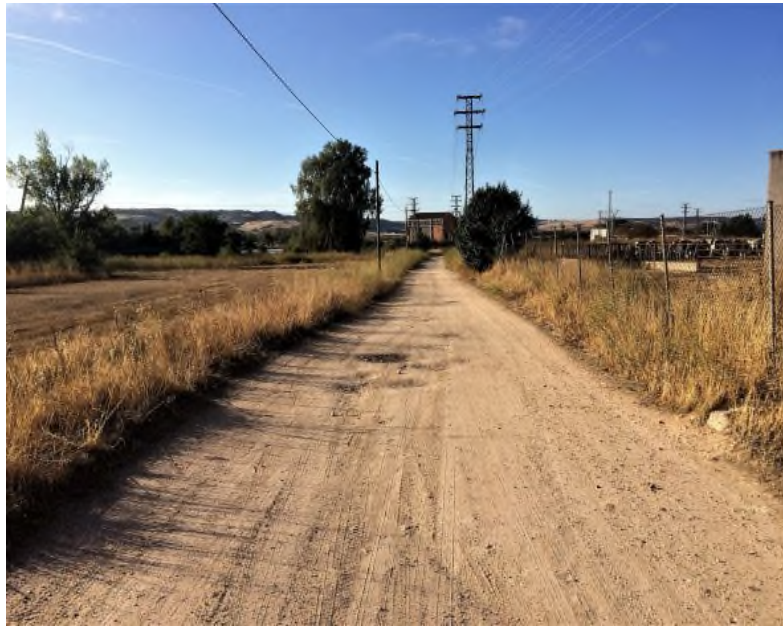
FOTO 35. Camino del Barro y de Cabañuelas, Tramo B
