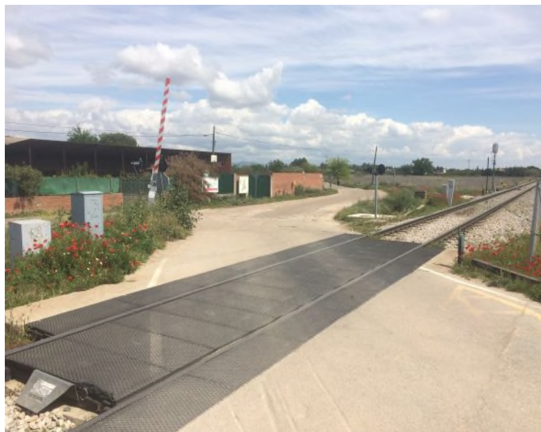
FOTO 2. Camino del Pilar, Tramo B
