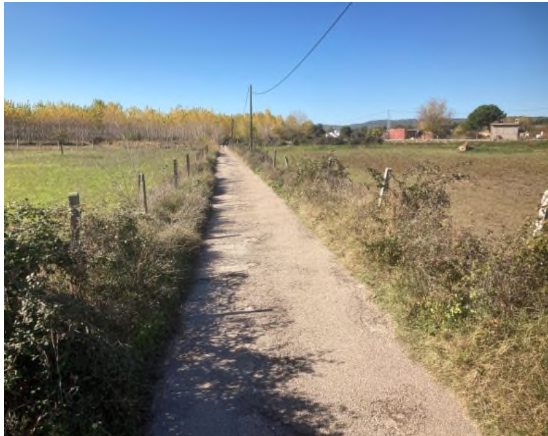
FOTO 17. Camino de Valdelacruz, Tramo D
