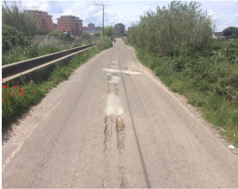
FOTO 5. Camino del Pilar, Tramo B
