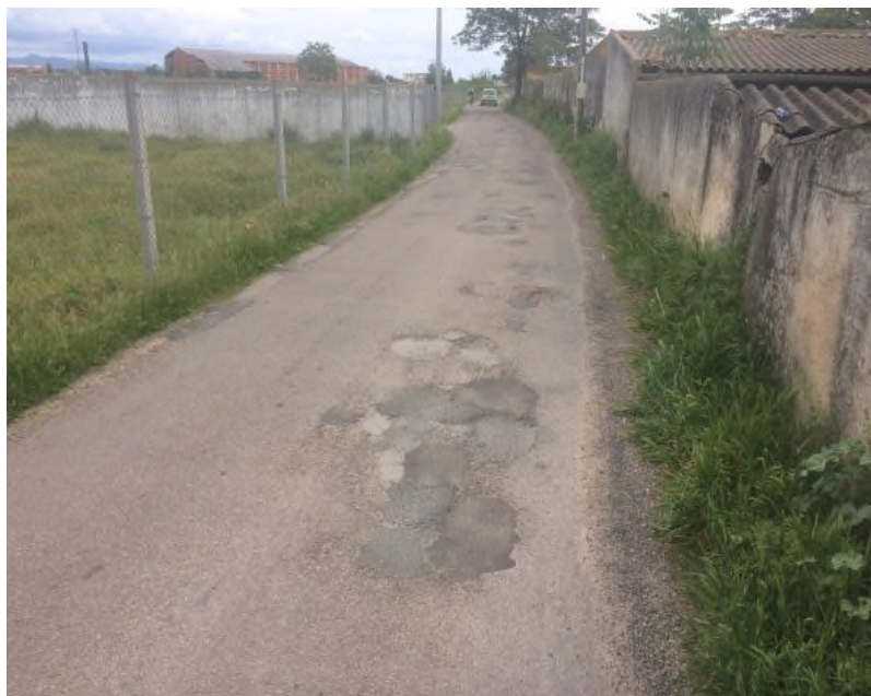
FOTO 8. Camino del Puntal, Tramo A
