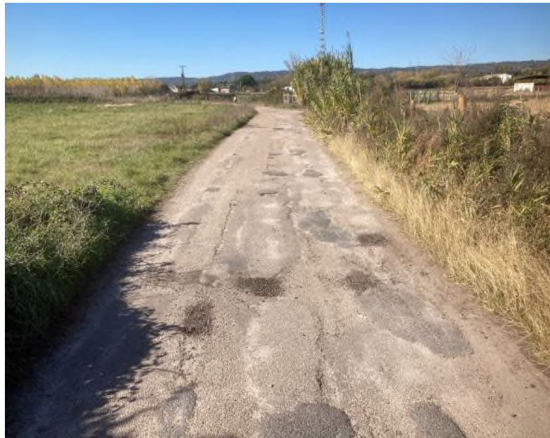
FOTO 16. Camino de Valdelacruz, Tramo D
