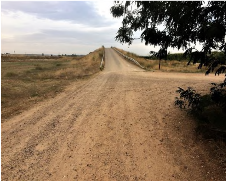
FOTO 40. Camino del Barro y de Cabañuelas, Tramo D
