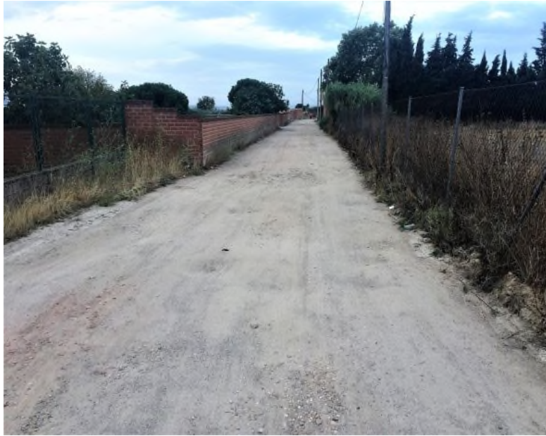
FOTO 39. Camino del Barro y de Cabañuelas, Tramo D
