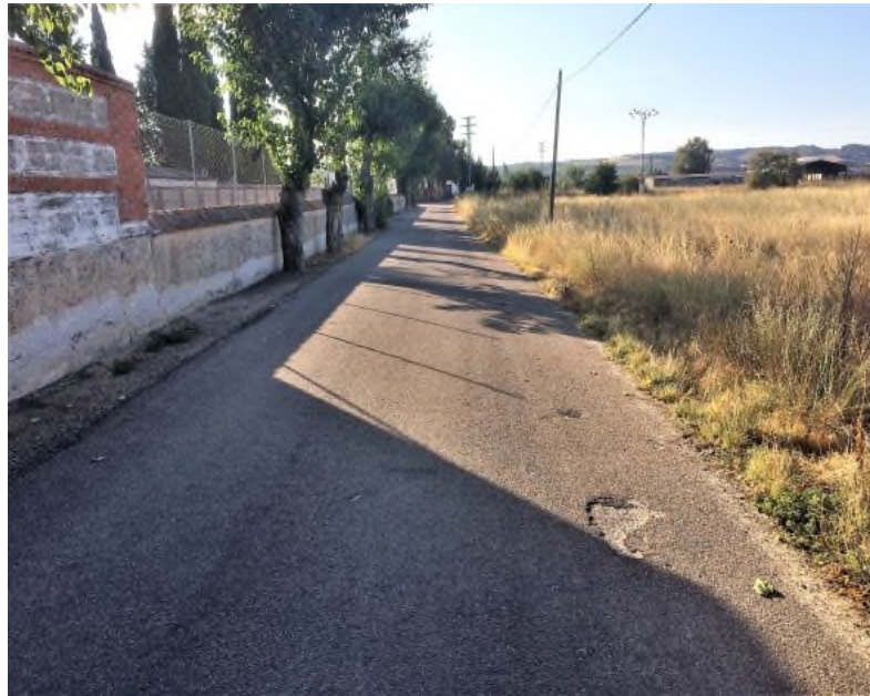
FOTO 33. Camino del Barro y de Cabañuelas, Tramo A
