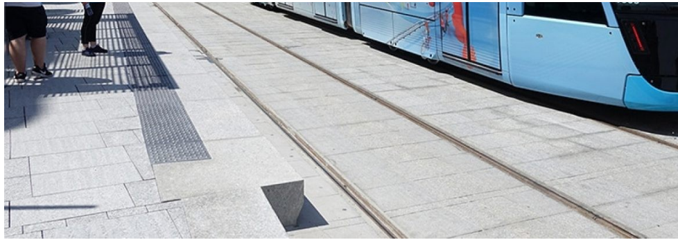
acera peatonal con baldosa de granito
