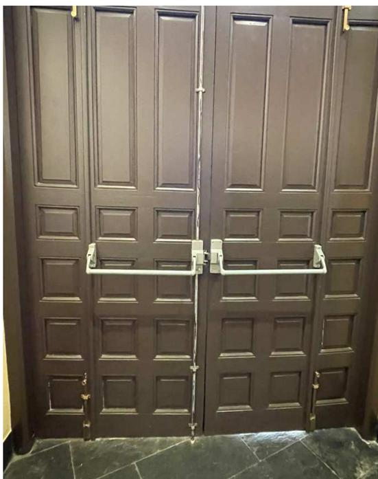
Foto: Estado actual de carpintería de madera, donde se puede observar, la falta de aislamiento.
