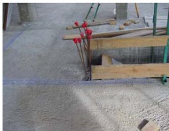
SEÑALIZACIÓN ZAPATAS Y ZANJAS PARA CIMENTACIÓN CON UNA PROFUNDIDAD >1 M. SE UTILIZARÁN BARRAS DE ACERO ALREDEDOR DE LAS QUE SE COLOCARÁ CINTA DE BALIZAMIENTO COMO DELIMITACIÓN A 2 ALTURAS. SEÑALIZACION DE ESPERAS DE PILARES Y MUROS CON SETAS PROTECTORAS. LAS ZANJAS Y ZAPATAS DE PROFUNDIDAD SUPERIOR A 1,3m, SERÁN ENTIBADAS DE ACUERDO A LO ESTABLECIDO EN LA NTE –ADZ/1976.
