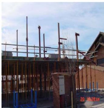
COLOCACIÓN BARANDILLA DE PROTECCIÓN EN EL ENTABLERADO (CUANDO NO EXISTEN REDES DE PROTECCIÓN PERIMETRAL), UTILIZANDO SARGENTO AJUSTABLE.
