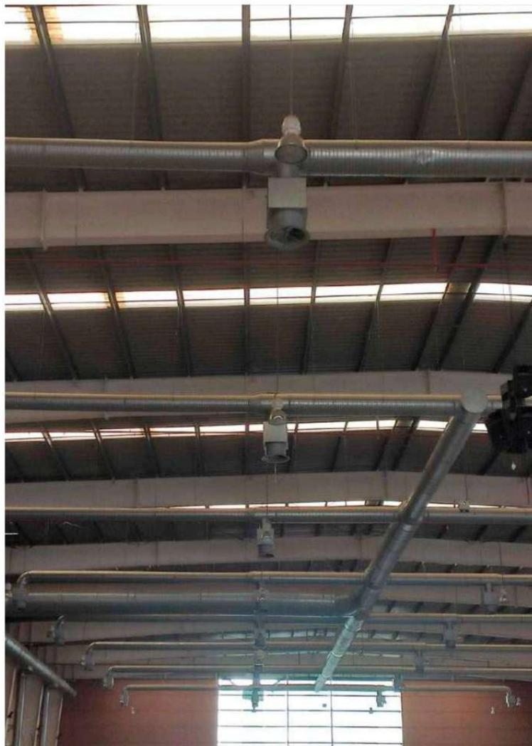
Los mismos climatizadores mediante otra red de conductos de retorno, diferente a la de impulsión, se encargan de aspirar el aire ambiente del interior de local a climatizar y volverá calentarlo, generando una circulación de aire que acabará cuando la temperatura ambiente del local sea la que queremos conseguir.
