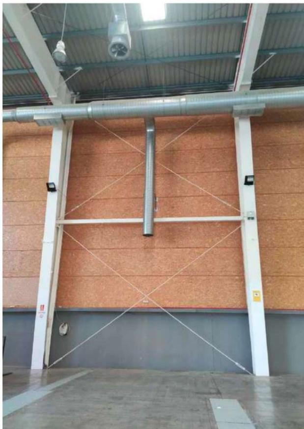
En la siguiente foto de muestra un ejemplo de la estratificación existente en la época de invierno en el pabellón 1, donde se puede observar como el humo artificial generado queda justo por debajo de los conductos de retorno, ya que el aire caliente que se encuentra en la capa superior pesa menos y hace que solo circule el aire de esa capa, evitando que la totalidad del volumen de aire del pabellón sea climatizado.
