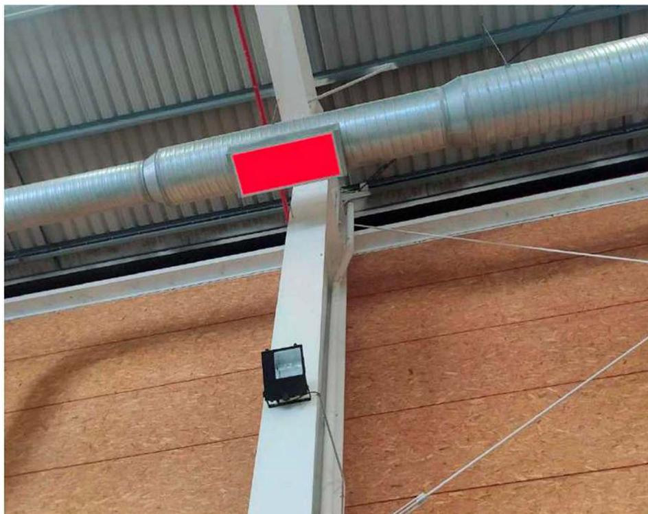
Regulación de la red de conductos de impulsión de tal manera que los difusores más cercanos a las rejillas de retorno estén un poco más cerrados, evitando que gran parte del aire tratado impulsado, sea absorbido y no realice el circuito de manera correcta.
