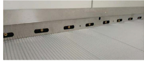
DETALLE DE SUELO CON ACABADO ANTIDESLIZANTE Y DIFUSORES
