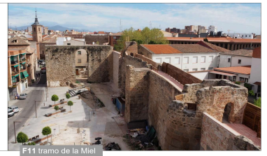
F11 tramo de la Miel
