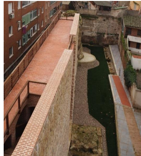
Tramo de la muralla en el sector de el Salvador que choca con una medianera
