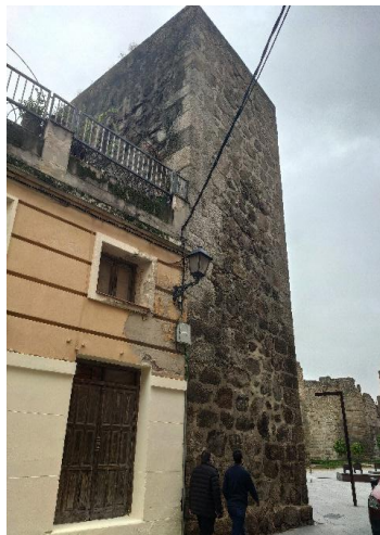
Torre albarra en el tramo Charcón II inaccesible por adosamiento de propiedad privada
