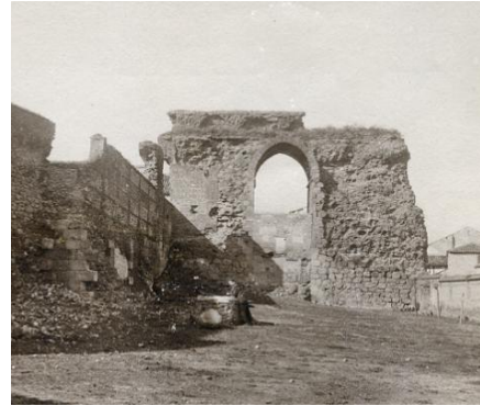
Detalle de imagen del exterior de la alcazaba con la torre albarrana T6 al fondo
