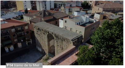
F14 tramo de la Miel
