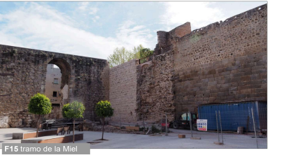
F15 tramo de la Miel
