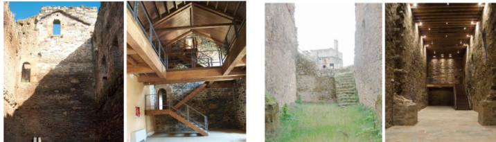
Comparativas fotografías antes- después intervención en el castillo de los Templarios de Ponferrada. F. Cobos estudio arquitectura
