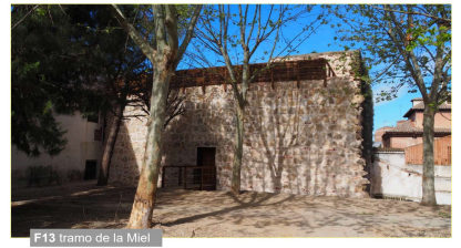
F13 tramo de la Miel
