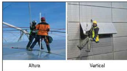
Figura 1. Ejemplo de trabajo en altura y vertical.
