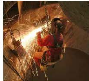
Figura 12. Trabajadores protegidos del riesgo de proyección de partículas.
