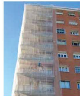
Figura 9. Instalación de una red de protección.
