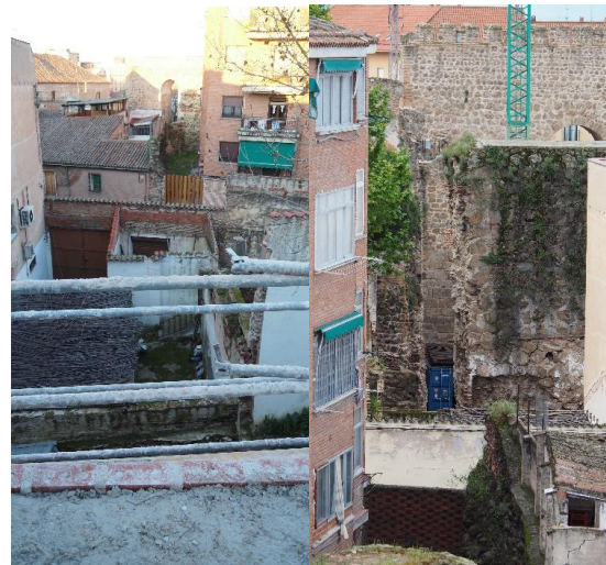
Vistas enfrentadas de los restos fraccionados de muralla entre el tramo Charcón II y Salvador I
