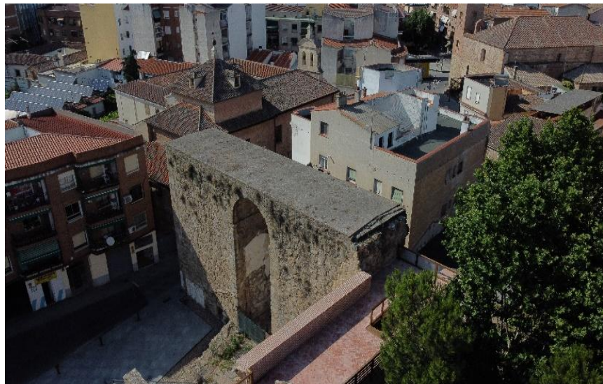
Torre albarrana en el tramo Charcón II
