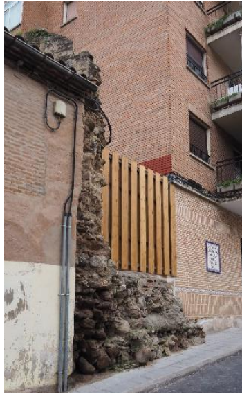
Restos de la muralla enmascarados tras edificaciones adosadas en el tramo Herrerías I
