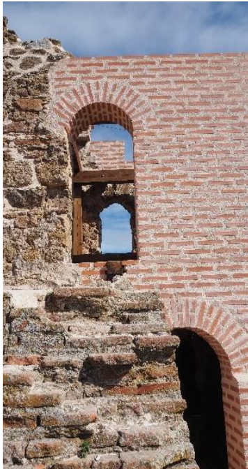
Intervención sobre torre T28 en el tramo Charcón
