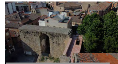
F11 fotografía aérea, conexión Charcón - Salvador
