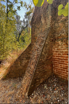
FOTO 1. Vista de los contrafuertes
