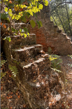
FOTO 2. Vista antepechos con 14 escalones
