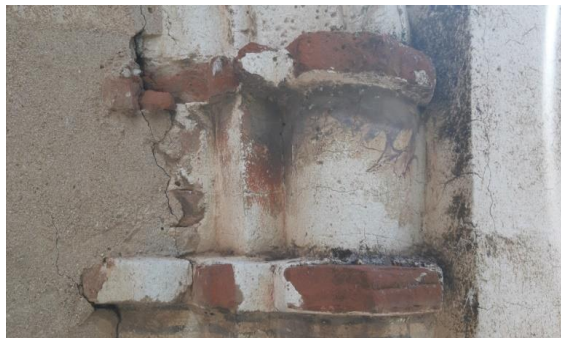
Fig. 107, 108 y 109. Piezas faltantes de aparejo en alero.
