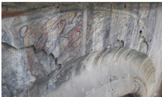
Fig. 59, 60 y 61. Acumulaciones de hollín sobre superficie pictórica.
