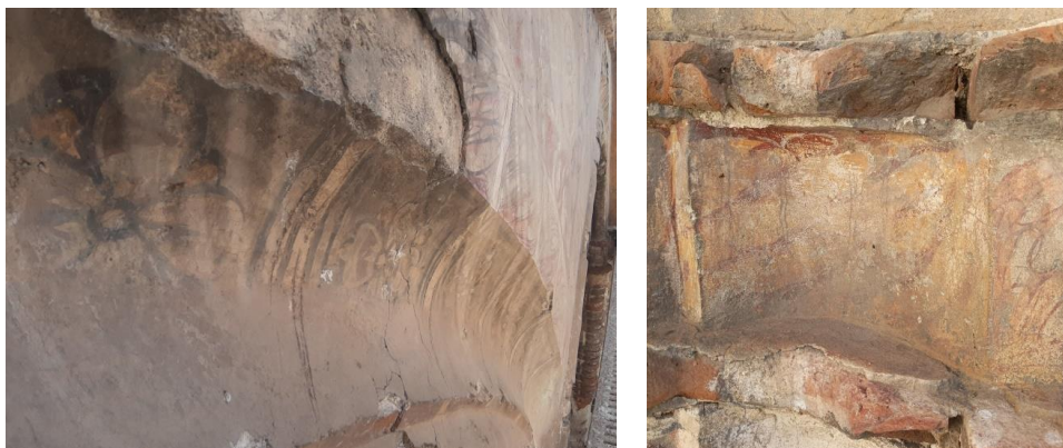
Fig. 140 y 141. Oxidación y envejecimiento (pátina).
