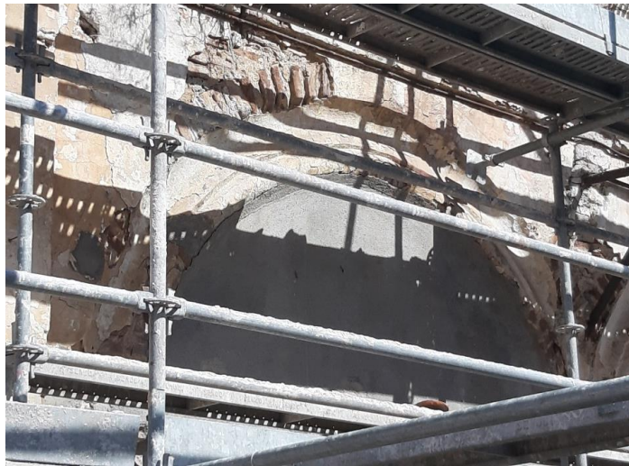
Fig. 25 y 26. Comparativa detalle arcada en fachada Sur Mayo 2022 – Septiembre 2022 – Octubre 2023.
