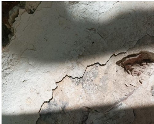
Fig. 68. Lechadas de cal sobre superficie pictórica.
