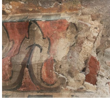
Fig. 107, 108 y 109. Piezas faltantes de aparejo en alero.
