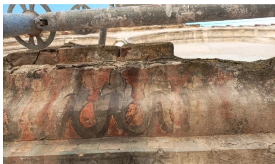
Fig. 86-89. Expolio o ausencia de secciones o modulaciones constructivas.
