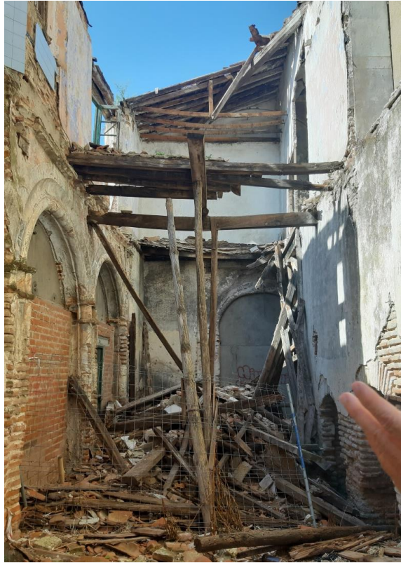
Fig. 21 y 22. Comparativa interior inmueble Octubre 2022 – Octubre 2023, ambas tras desprendimiento de vigas y cargadero de primera planta ocasionado por desplome de fachada Sur.
