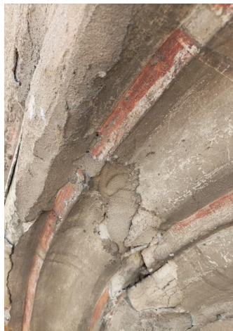
Fig. 62-67. Intervenciones anteriores con cemento Portland y Yeso.
