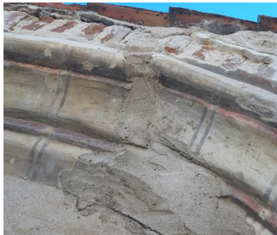
Fig. 62-67. Intervenciones anteriores con cemento Portland y Yeso.
