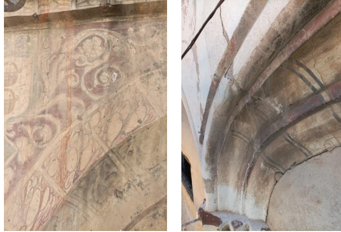
Fig. 46 y 47. Agua de escorrentía (lavado de piezas de ladrillo) sobre superficie pictórica.
