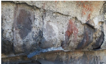
Fig. 142-157. Abolsamientos/desprendimientos – Descohesión de revocos y enlucidos.
