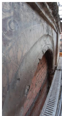
Fig. 48-56. Suciedad superficial y ennegrecimiento de superficie pictórica.
