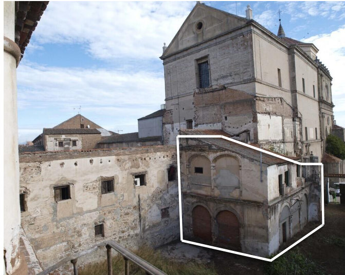
Fig. 5. Edificio a tratar.
