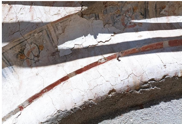
Fig. 69, 70 y 71. Sucesivas capas de lechada de cal sobre superficie pictórica.
