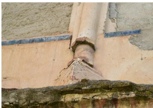
Fig. 90 y 91. Tira de Piezas cerámicas de alizer (en arcada de planta superior de fachada Oeste) en mal estado de conservación y falta de vidriado.
