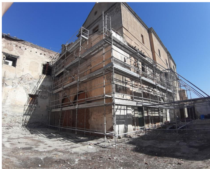
Fig. 8 y 9. Apeo y arriostramiento de Fachada Sur (año 2023).
