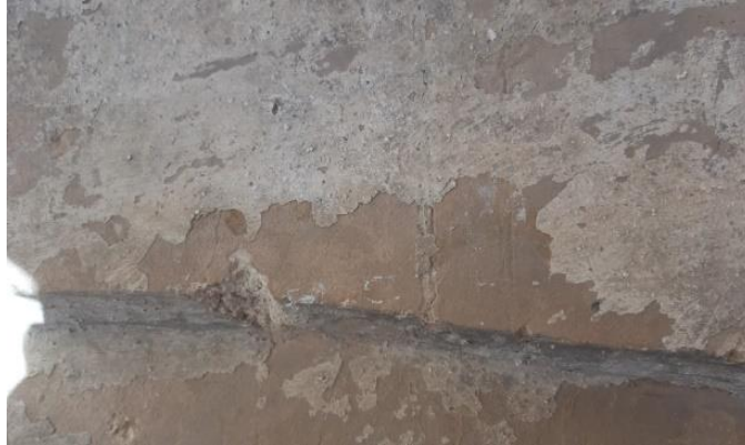
Fig. 68. Lechadas de cal sobre superficie pictórica.
