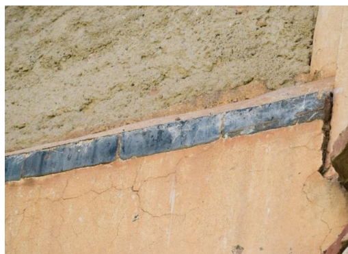
Fig. 90 y 91. Tira de Piezas cerámicas de alizer (en arcada de planta superior de fachada Oeste) en mal estado de conservación y falta de vidriado.
