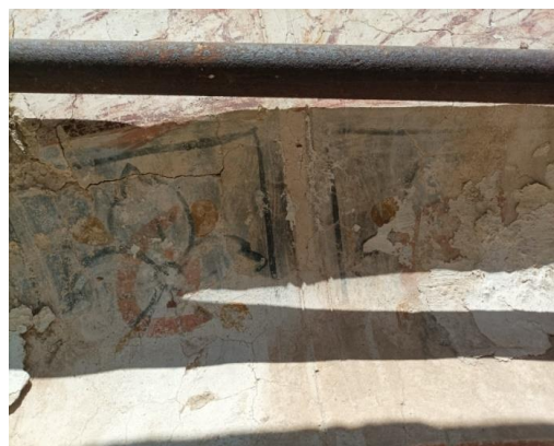
Fig. 92-106. Superficie pictórica disgregada, erosionada, abrasada o pulverulenta.
