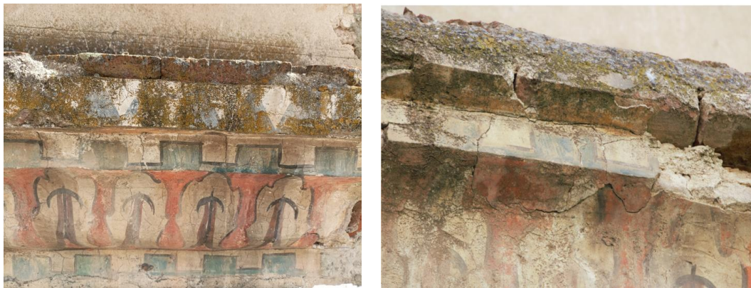
Fig. 29 y 30. Acumulación de musgo y verdín en alero y sobre superficie pictórica.
