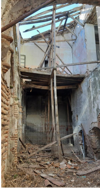
Fig. 21 y 22. Comparativa interior inmueble Octubre 2022 – Octubre 2023, ambas tras desprendimiento de vigas y cargadero de primera planta ocasionado por desplome de fachada Sur.
