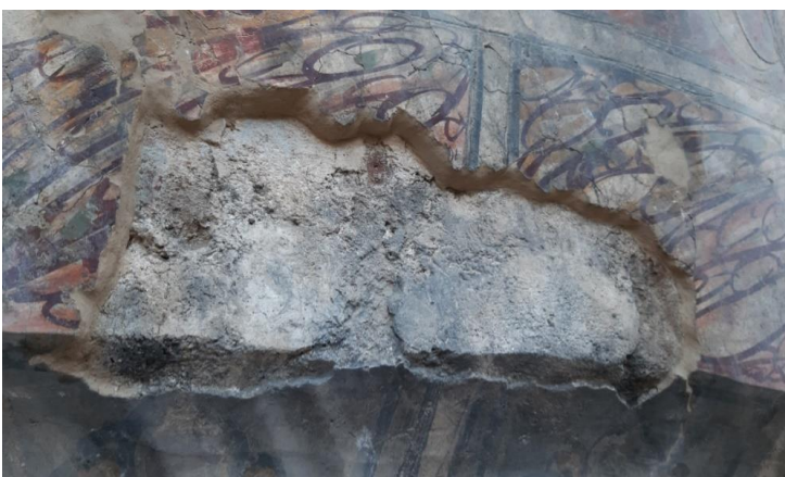
Fig. 161-170. Comparativa de cosido de bordes, inyección de abolsados y sellado de fisuras durante los trabajos de consolidación de pinturas murales en Octubre de 2022.
