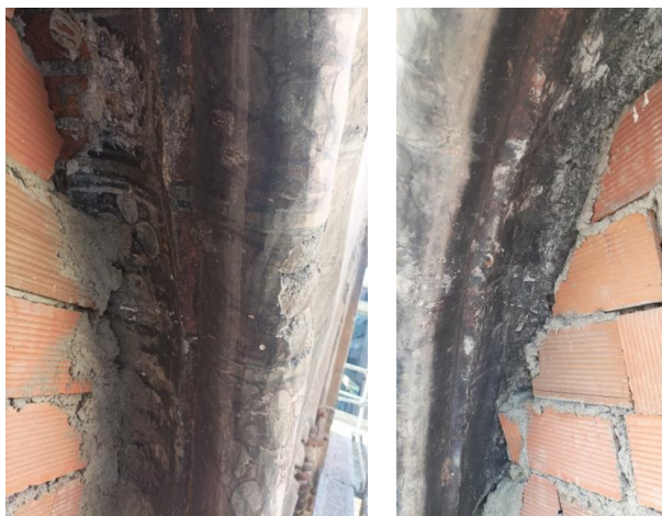
Fig. 57 y 58. Hollín sobre superficie pictórica.
