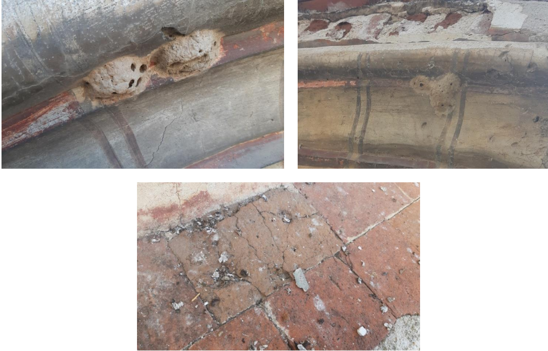
Fig. 40, 41 y 42. Anidamientos (avisperos) y heces de paloma sobre vierteaguas.
