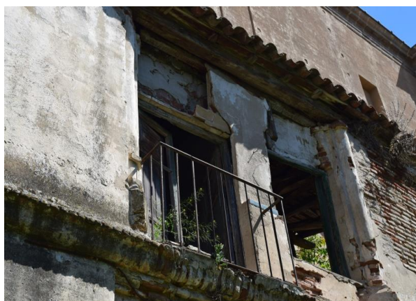
Fig. 81. Antigua intervención de añadido en segunda planta de Fachada Sur.
