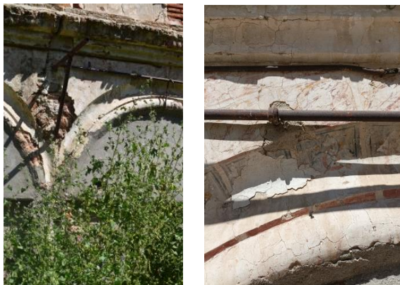
Fig. 72-80. Presencia de elementos metálicos y sistemas de iluminación antiguos.
