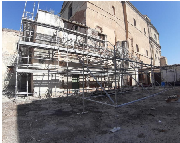
Fig. 16, 17 y 18. Comparativa fachada Sur Mayo 2022 – Septiembre 2022 – Octubre 2023.
