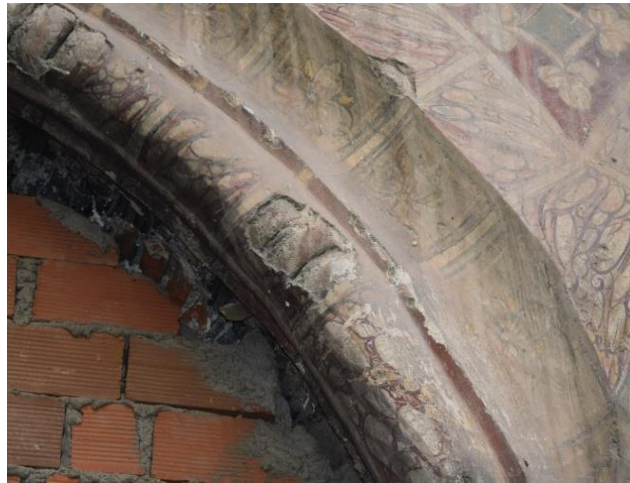
Fig. 46 y 47. Agua de escorrentía (lavado de piezas de ladrillo) sobre superficie pictórica.
