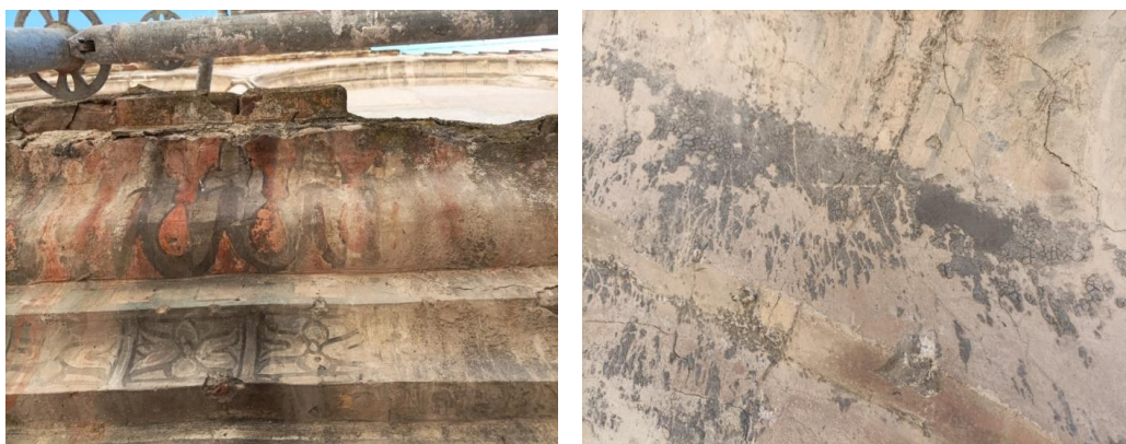
Fig. 57 y 58. Hollín sobre superficie pictórica.
