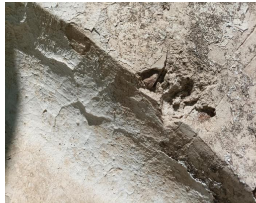
Fig. 68. Lechadas de cal sobre superficie pictórica.
