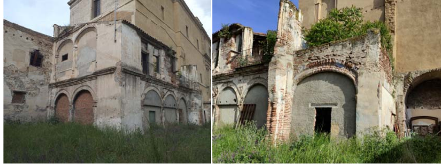
1 – Fachadas oeste y sur 2 – Fachadas sur y este
