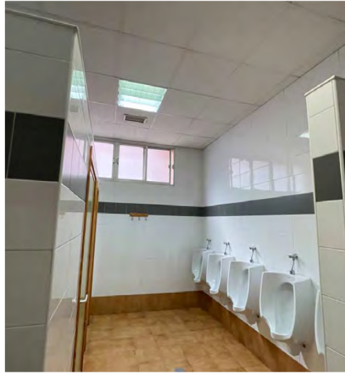
Foto: Ejemplo de ubicación de futura instalación de detectores de movimiento.
