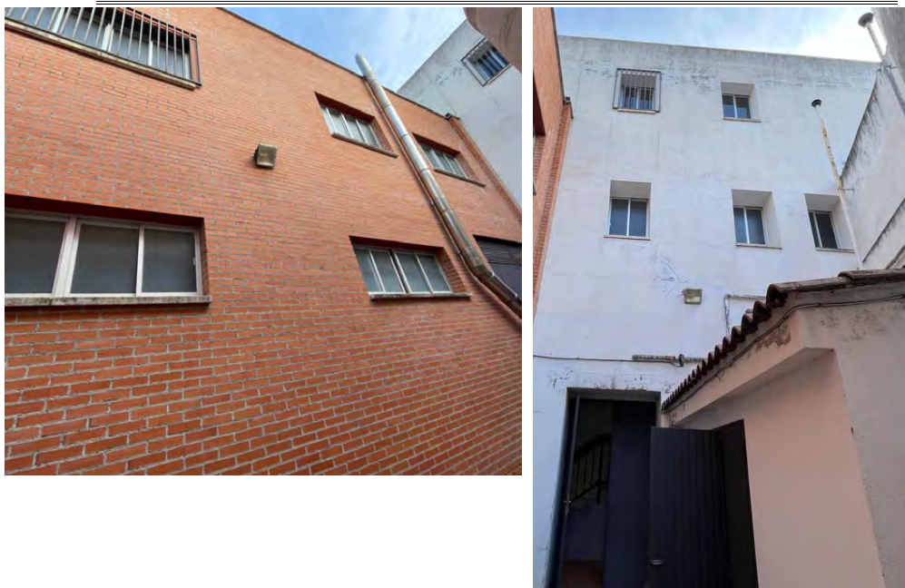
Fotos de muro a patio interior a trasdosar por el exterior.
